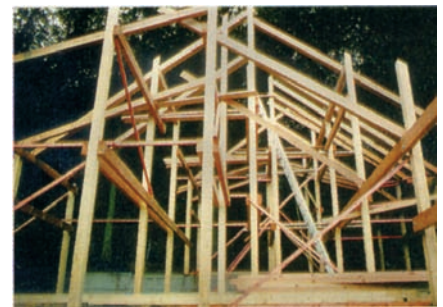
12 Tragende Holzskellettstruktur der GK 0
