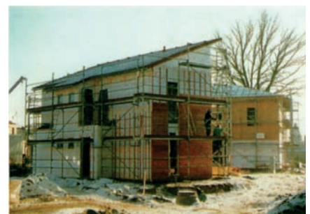
13 Äußerer Schutz der Bauteile durch wasserabweisende, diffusionsoffene Folie
