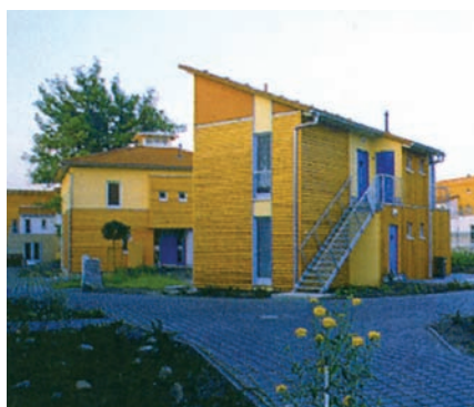
20 Kombination Stülpzalung (hinterlüftet) /Wärmedämmverbundsystem
